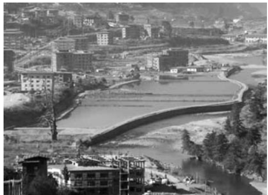
写真-3 ブータンのバベサ下水処理場
